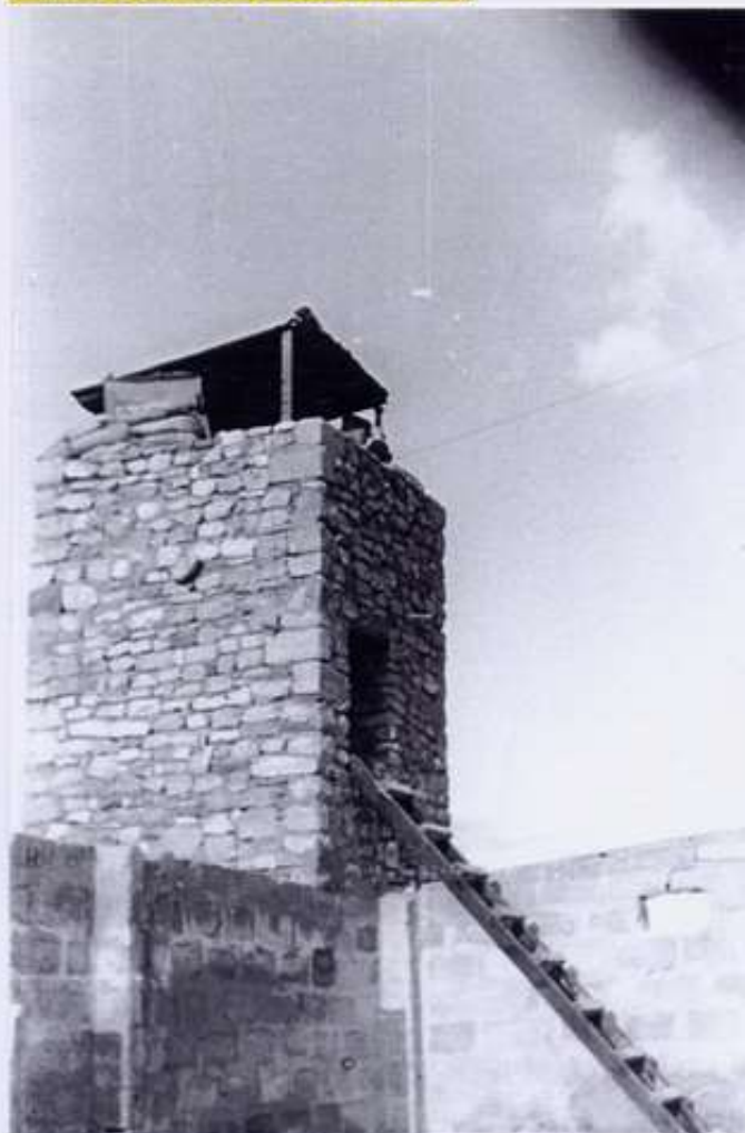
Mirador Nord du poste
