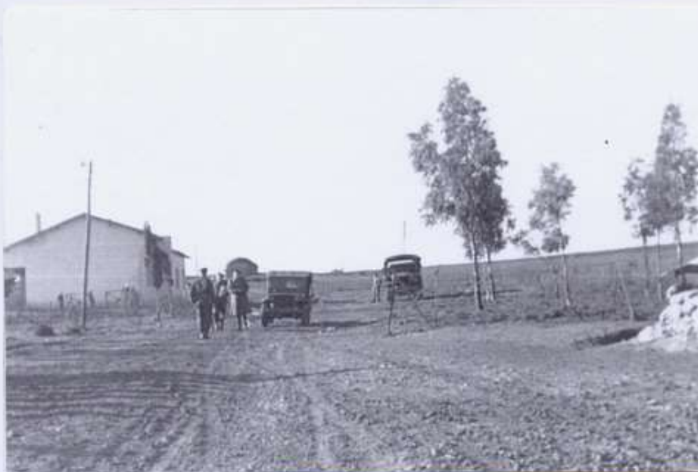
Bâtiments de la harka à proximité du poste de BIR-AMAR
