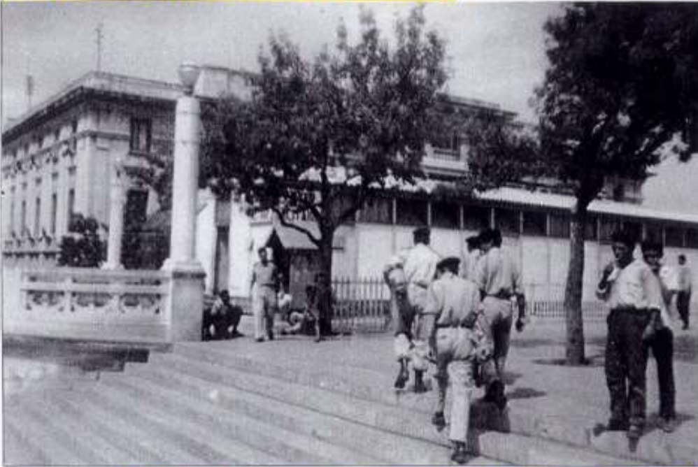
Au fond : mur d'enceinte de l'hôpital militaire LAVERAN
