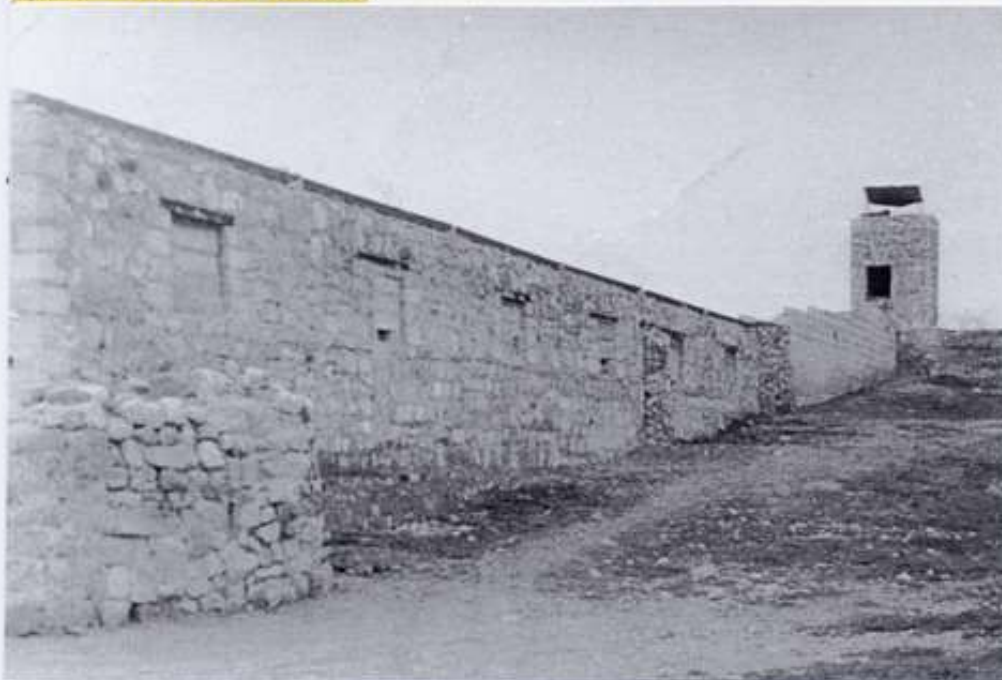
Mur "est" du poste
